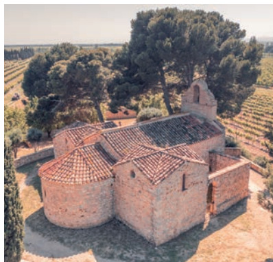
Chapelle de Garrieux
