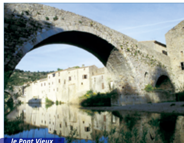
Le Pont Vieux
